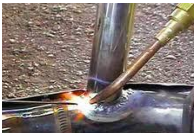
Рис. 5.29. Работа с газосварочной горелкой
