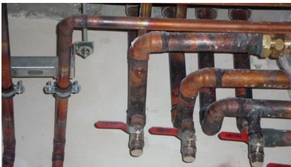
Рис.5.52. Сварка медных труб
