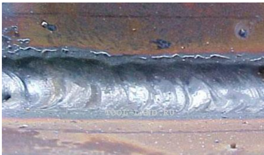
Рис.13.67 Подрезы в сварном шве
