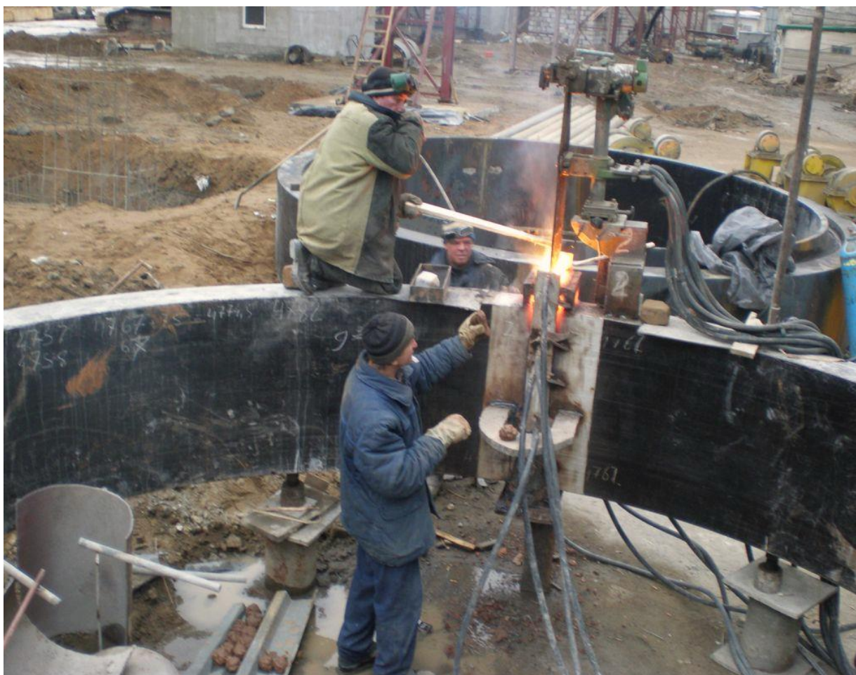
Рис.5.21. Электрошлаковая сварка ковanej конструкции
