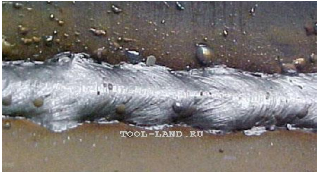
Рис.5.63 Наплывы в сварном шве.
