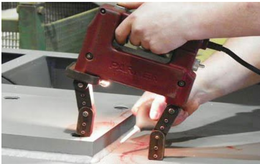
Рис.5.69 Проверка качества сварных швов магнитной дефектоскопией
